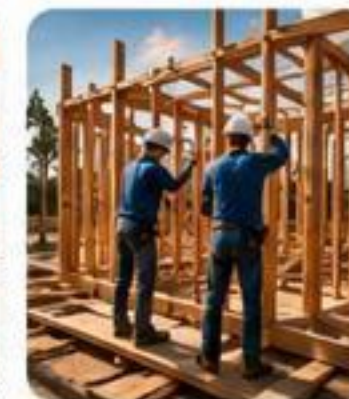
PENDANT LES TRAVAUX
