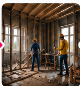
PENDANT LES TRAVAUX
